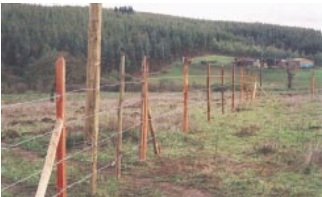
Figura 18: Cercado perimetral con cuatro hebras de alambre de púas.
