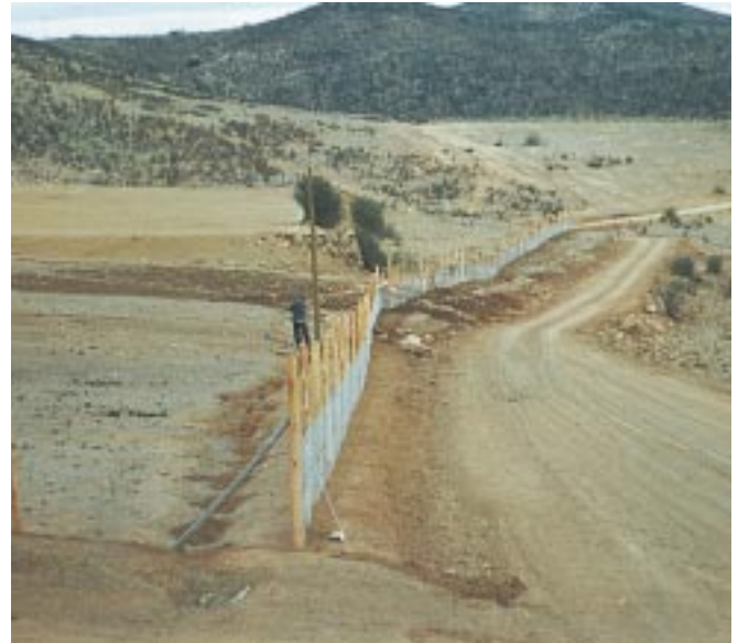
Figura 19: Cercado con malla Ursus y dos líneas de alambre de púas.
