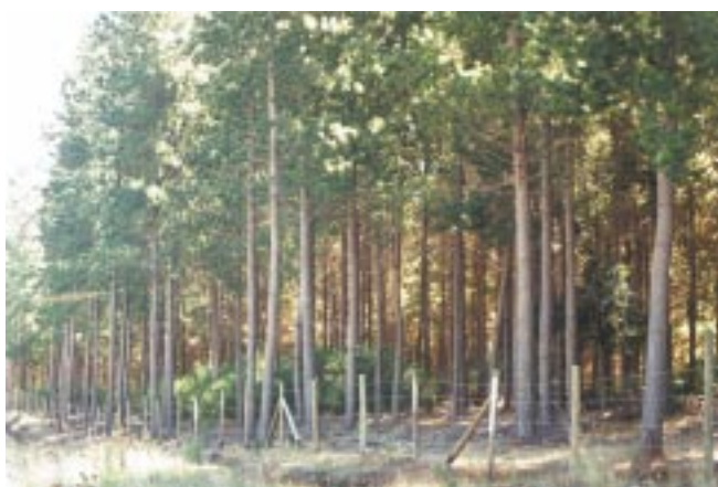
Figura 24: Construcción de cerco con polines impregnados y cuatro hebras de alambre.
